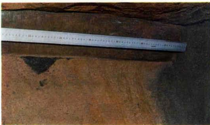
写真-4 PC-9-1のGL-8.4m 付近のくい周地盤状況
