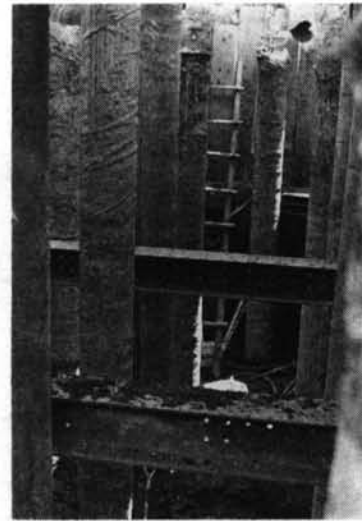
写真-1 手掘りによるGL-4.0～6.0mの掘削状況
