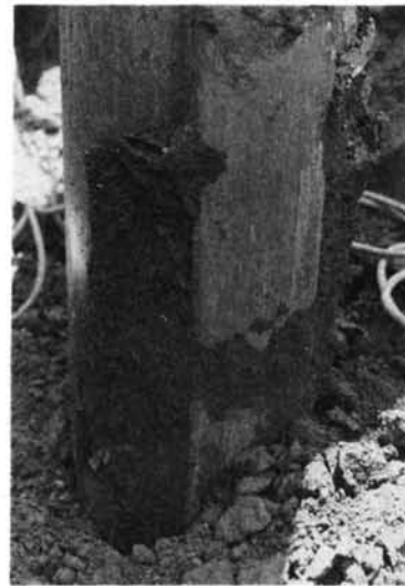
写真一四 引抜き試験終了後のくい頭の状況(SP-10)
