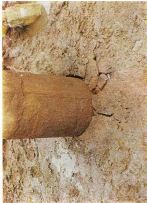
写真-13 引抜き試験終了後のくい頭と地盤の状況(PIP-7)
