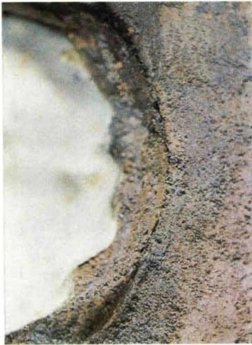
写真-12 引抜き試験終了後のくい頭と地盤の状況(SSS-3)
