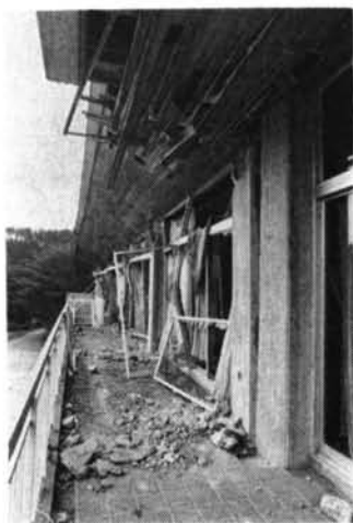
図一13 15通り柱亀裂状況
