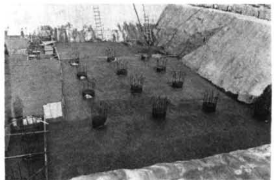
写真-1 掘削後ステコン打設終了時の状況
