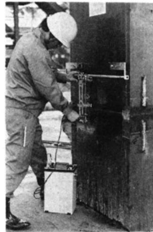
写真一3 タンデム法による現場探傷風景
