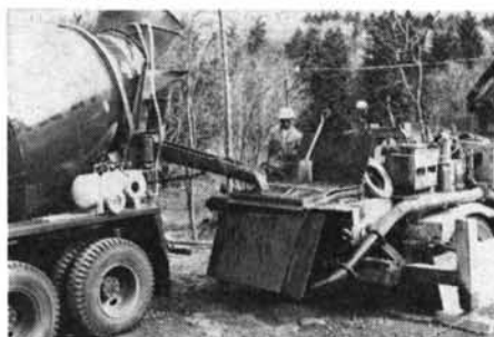
写真二 添加装置取付ミキサー車
