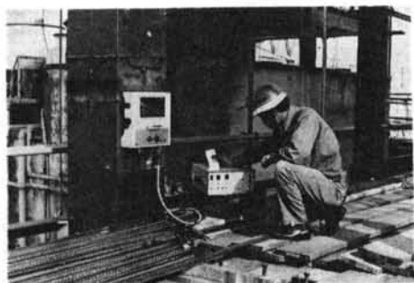
写真-2 現場溶接部の探傷風景
