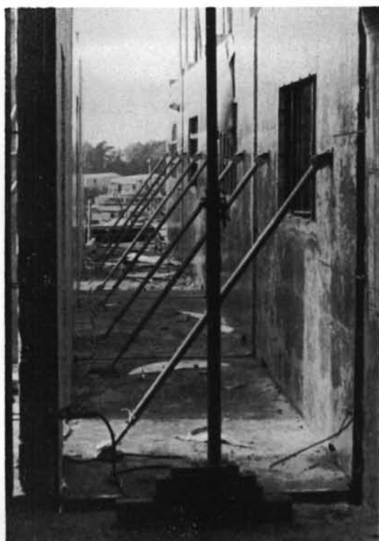
写-61 さきの実験家屋で性能を確認されたブレースサポートが、本格的に用いられた(版1枚につき2本使用)。
