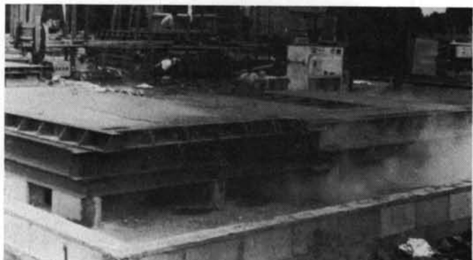
写-42 蒸養定盤の上の型わくにコンクリートをうち、蒸気を通しはじめたところ。コードは温度計測用の熱電対のもの。
