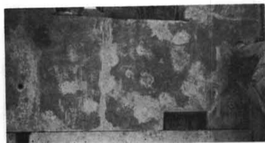
写-15 はくりシートの穴からセメントペーストがもれたため下の版に生じたよごれ。簡単には取り除かれない。
