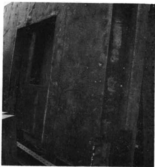
写一20 0.3mm厚のポリエチレンシートを、はくりシートとした場合のコンクリートの肌。ボチボチは「踏み穴」によるものである。
