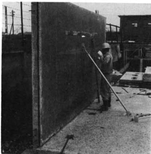
写-29 仮止めブレースをかい、建入れを修正する。小口黒いのはコムブリバンド=防水シール。
