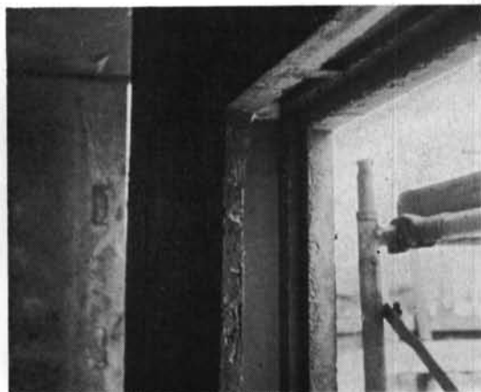
写-5 すてわく型あと付方式—脱型したところ。
