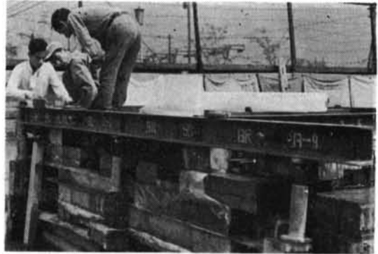
写一14 周辺型わくの支持方法は版精度に大きく影響する。
