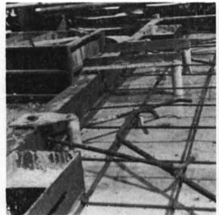
写一47 版に正確に穴をあけるための型わく(治具)。白いのは脱型を楽にする紙スリーブ
