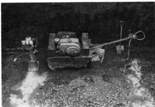
写真-3 砂礫層締固め機械
