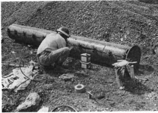
写真-5 No.13杭のケーシング鋼管ジョイント部の防水
