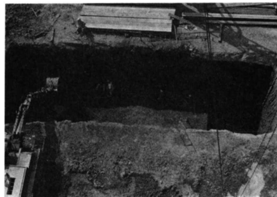
写真-1 現地盤(関東ローム)の掘削
