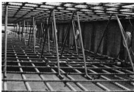
写真-1 計測器の取付け状況 (A現場)
