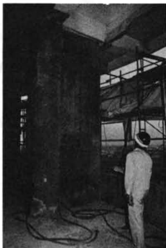
写真—4 4階外柱の径方向に付加された袖壁（3階にはこれを受けるバットレスが設けられた）
