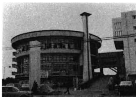
写真一 1 2月20日地震直後の様子(4階ガラス窓の被害の様子がわかるであろう)
