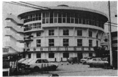
写真-6 補強工事終了後の全景
