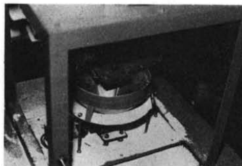
写真-2 投入用ホッパー周辺
