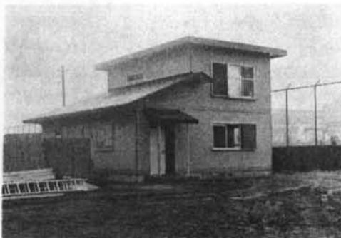
写真—1 パーティクルボード試作住宅
