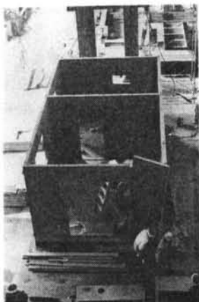
写真一2 実験建物：1階壁パネル建方
