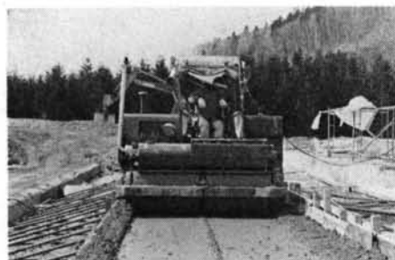
写真-2 試験ヤードにおける施工実験
