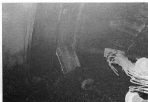
写真-3 圧縮強度試験用パネルへの吹付け
