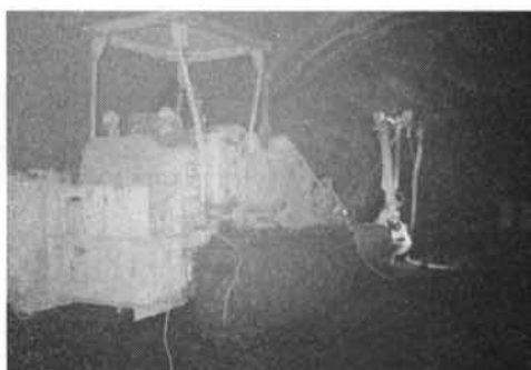
写真-2 吹付けロボット
