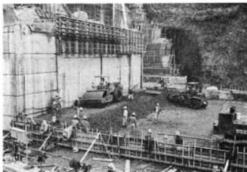
写真一1 RCDコンクリート打設状況
