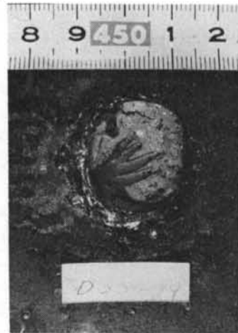
写真一2 欠陥の発生状況
