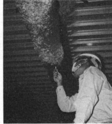
写真一三 吹付け厚さの測定
