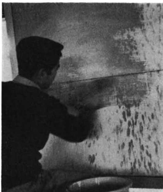
写真四 シボレックス面をフォームラー15倍液で湿す。
