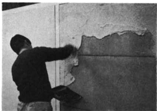
写真五 メトロズ混入B-YNプラスター下塗り (調合 1:15, 塗厚 8~9 mm)
