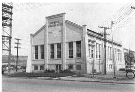
写真-1 El Centro アレー #9の地震計が設置されている変電所建物
