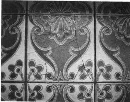
写真一 1 クリンカー張り工法で張られた陶器質タイルの衝撃破壊の例
