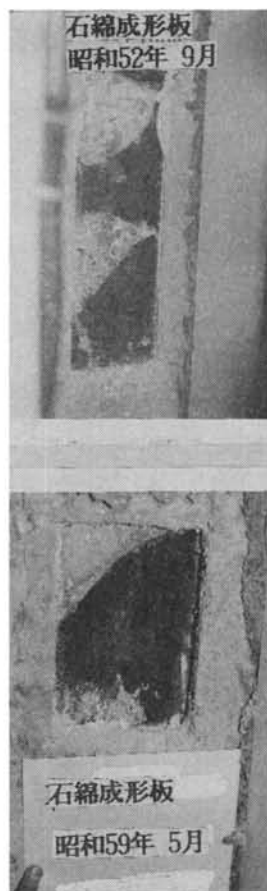
写真-1 Aビルの鉄骨の状態
