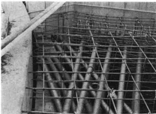
写真-2 シースとダクトとバットレス内の配筋
