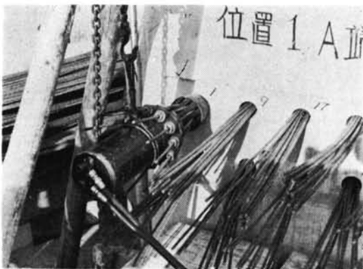
写真-5 フレシネジャッキ装置
