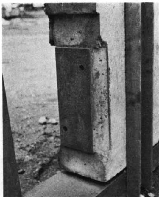
写真 1-2 SBの仕上り状態(ビス穴は型枠への取付用)
