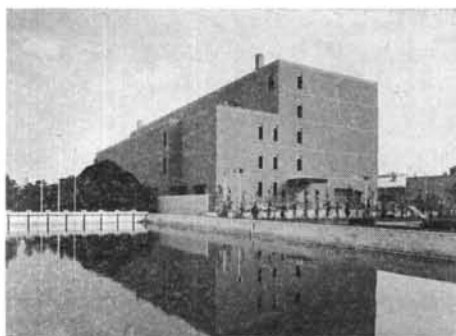
写真-11 構造物外観
