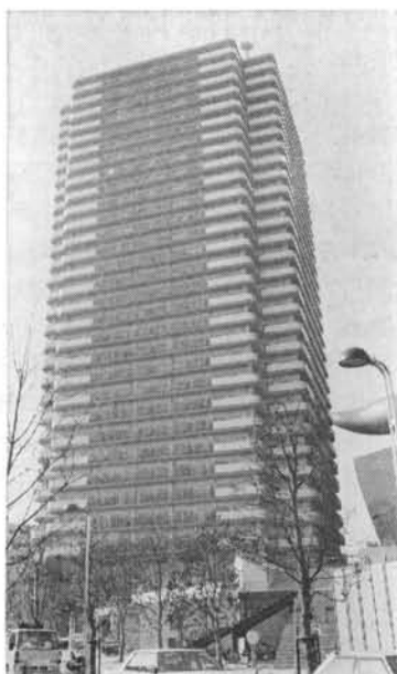
写真-12 構造体外観
