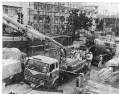
写真一六 実大実験におけるコンクリートの打込み
