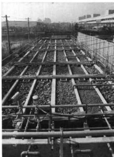
写真-1 実験水路(手前:流入部,奥:流出部)
