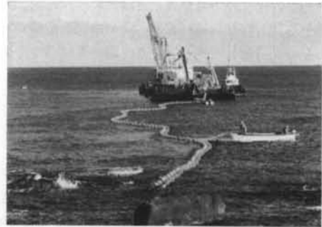
写真一1 管陸上げ状況
