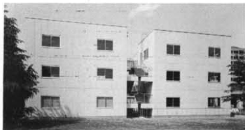
写真-1 免震構造実証試験建屋
