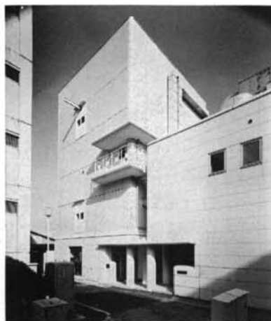
写真-1 観測建物の外観
