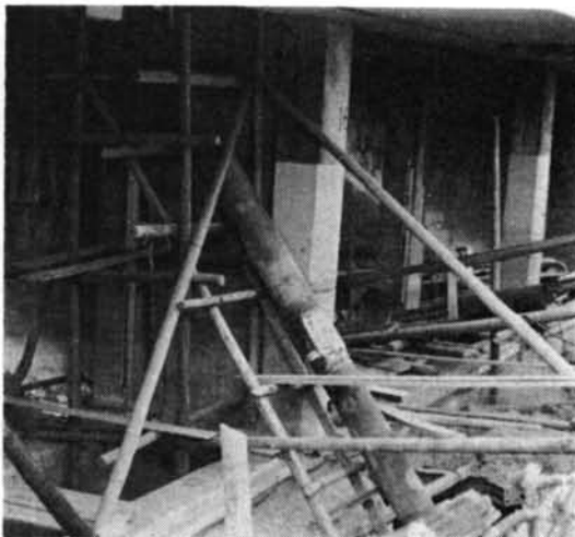
写真-9 斜め支柱とその応力測定
