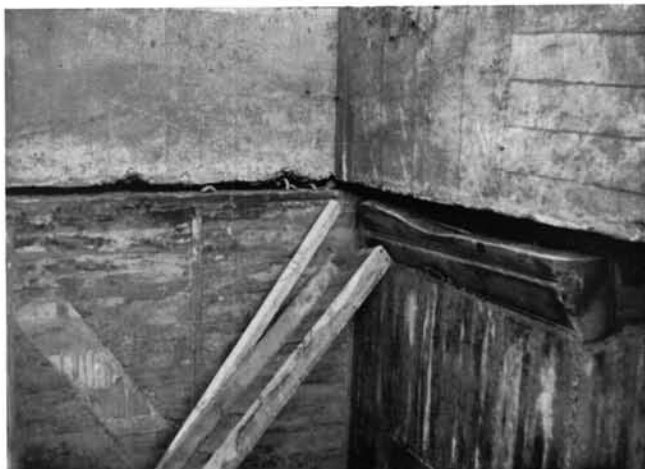
コンクリートと基礎のすき間にはプレパクトモルタルをグラウト
