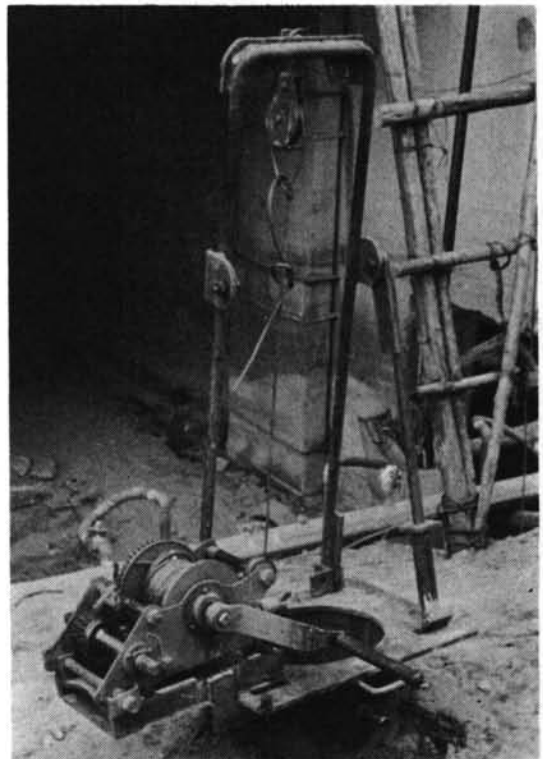
写真—5 改造後のサンドポンプつり下げ治具 (手巻きウインチを取付けた)
