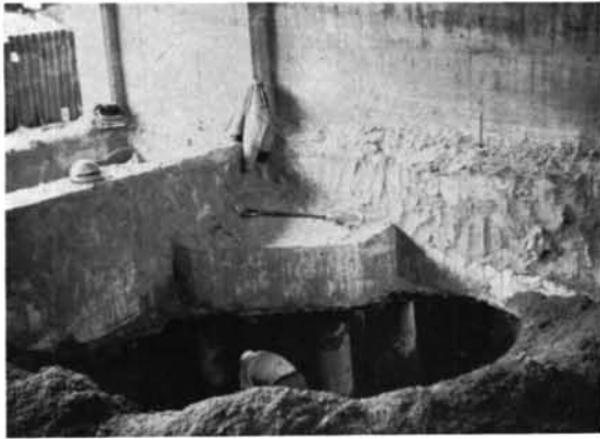
新棟基礎下の根切り
