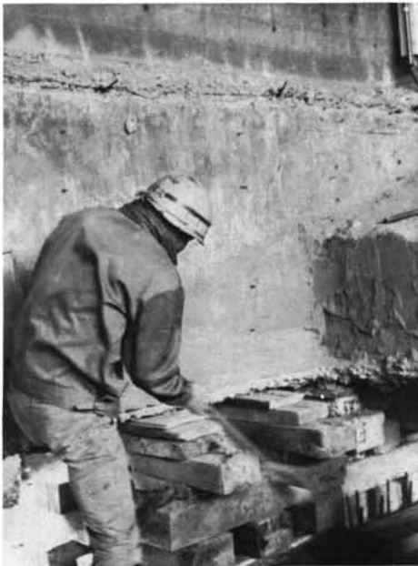
地中ばりの下端にもくさびを打ち込む
