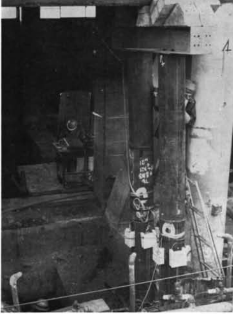
仮受け鋼管にかかる応力の測定
