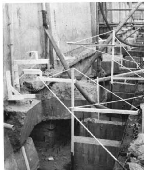
建物の水平移動の測定器
