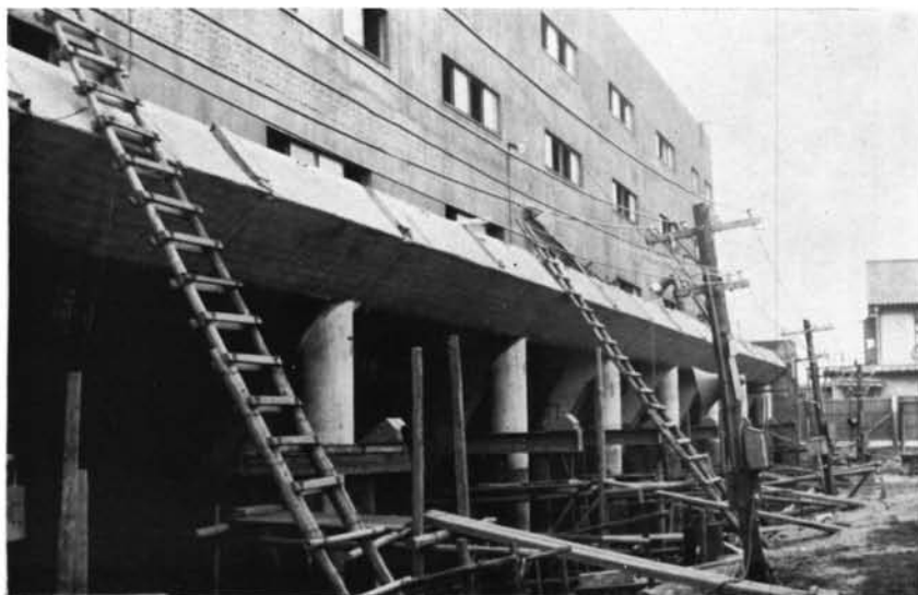
修正完了、かつてこのはりは仮受けの上にあった
