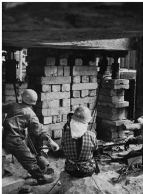
盛替え、ジャッキアップが繰り返される
