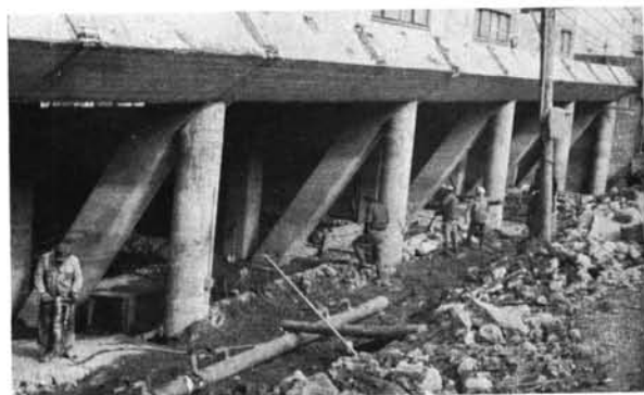
土間コンクリートのこわし
