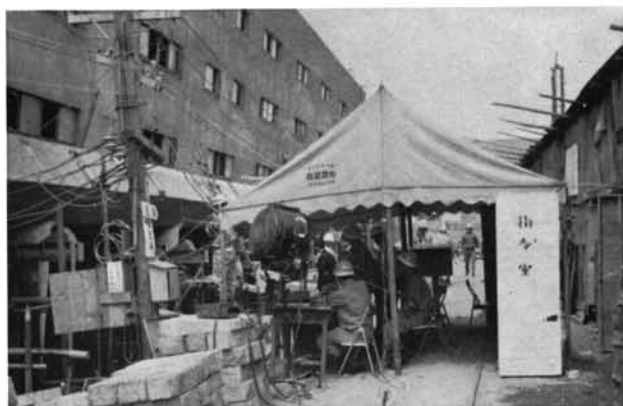
扛上作業に備えて中央指令室を設ける
