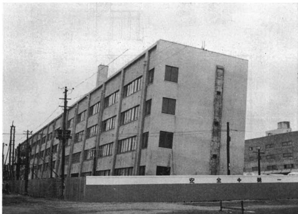
写真一 復元工事着工前の建物全景
