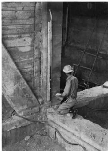
各柱のウォーターレベルを測定し報告する
