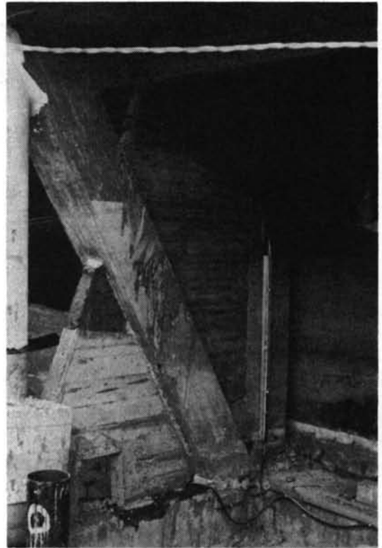
写真-11 1階各所のウォーターレベルとジャッキアップのための補強壁
