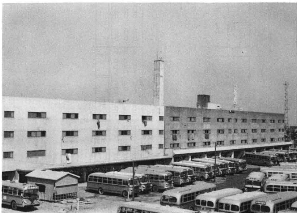
写真二 復元工事完了後の建物全景
