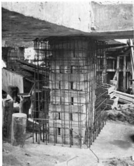
鉄筋は耐圧版の差筋に溶接される。
