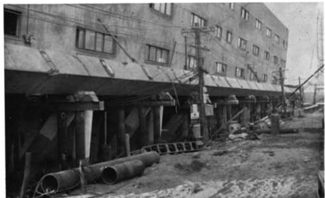
旧棟建物の圧入鋼管による仮受け
