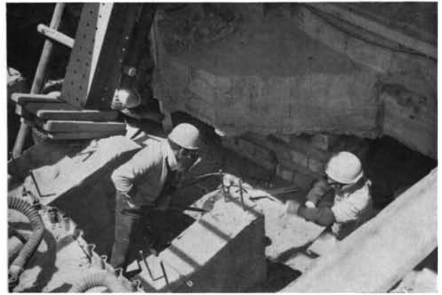
号令に合わせてジャッキを作動する
