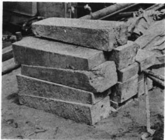
写真一10 コンクリート製くさび
