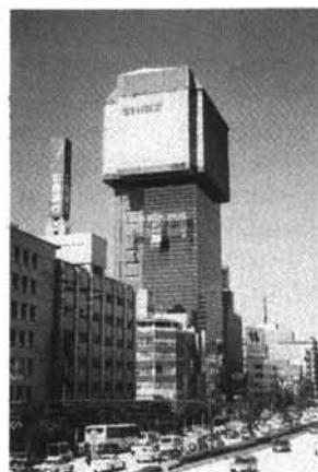
写真-1 施工中の外観
