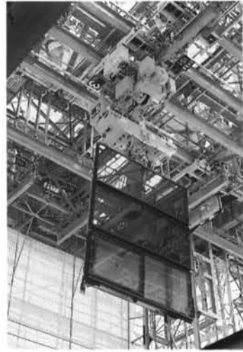
写真-5 外壁パネルの搬送
