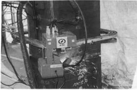
写真-4 作業中の溶接ロボット
