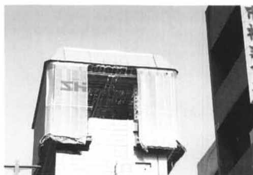
写真-7 外周養生の解体
