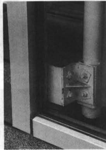
写真一9 ガラススクリーン構法の被害(神戸市東灘区) シーリング材のせん断破壊
