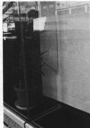
写真一10 ガラススクリーン構法の被害(神戸市東灘区) 方立ガラスのひび割れ
