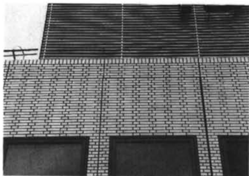
写真一 1 PCaカーテンウォールの被害（芦屋市）PCa板のずれによる目地幅・目地芯のずれ
