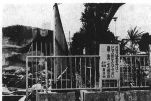
写真-4 空地にある残存建築物
