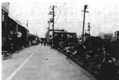
写真-3 延焼地域と狭い道路を介している木造の残存建築物
