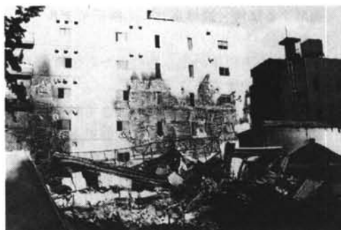
写真-7 火災の痕跡
