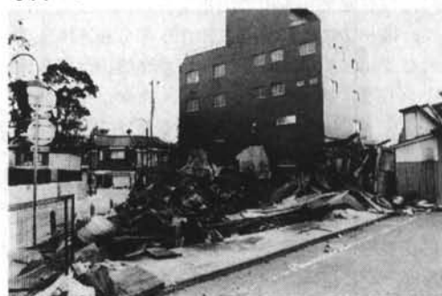
写真-6 単体火災周囲の焼け止まり
