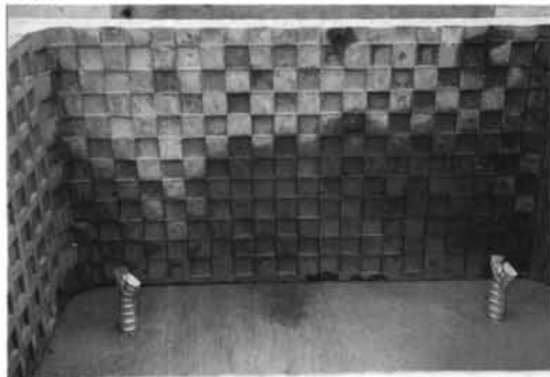
写真-4 打継ぎ境界面の仕様 (角型コッター・千鳥)
