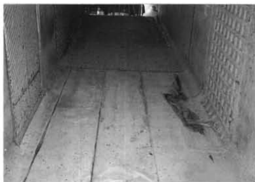
写真-1 打継ぎ境界面の仕様 (平滑)
