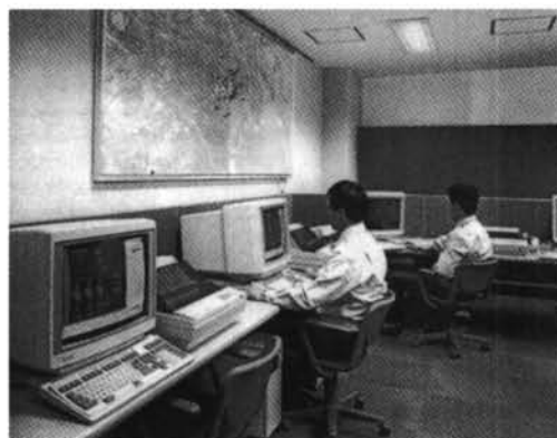
写真-1 シミズビル総合管理センター
