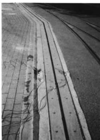
写真-2 センサー設置状況
