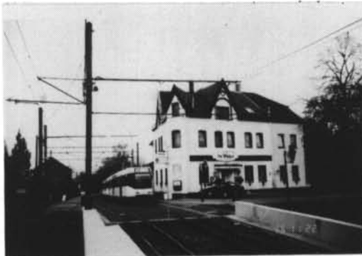
写真-1 ドイツの市電のフローティングスラブ軌道
