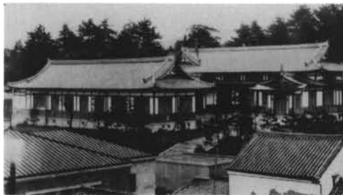
写真一 奈良基督教会・外観 (奈良基督教会所蔵)
