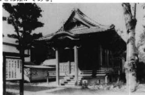
写真一七 彦根聖愛教会・正面外観 (宮川庄助旧蔵)
