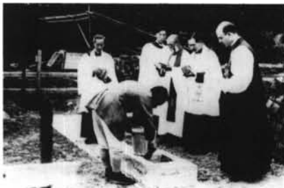
写真-3 奈良基督教会・定礎式 (日本聖公会京都教区資料室所蔵)
