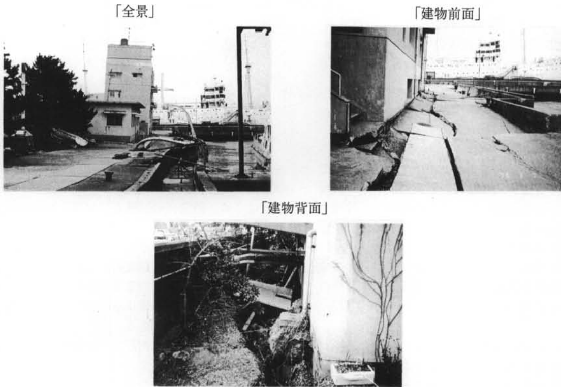
写真-6 神戸商船大学の3階建て「海技実習センター」被災状況 (東京大学 若松加寿江氏より提供)
