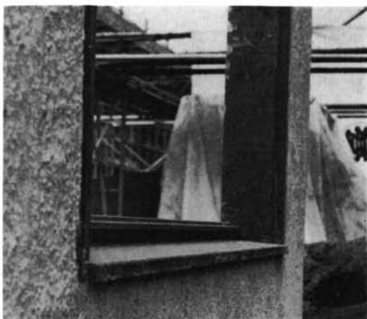
写真-20 壁と同じ見込厚をもったスチールサッシウ (打込面側)
