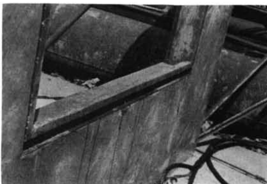
写真-21 壁と同じ見込厚をもったスチールサッシウ (定盤側)
