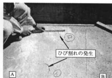
③ 仕上げ方法 A により発生した初期収縮ひび割れ
