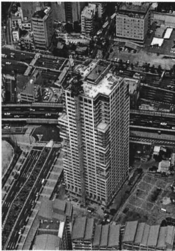
写真一 1 施工中の建物全景
