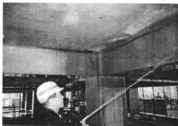
写真一 5 散水養生
