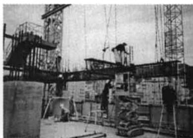
② 地組はり筋の吊り込み はり鉄筋の継手処理
