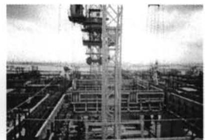
③ システム型枠建込み PCa小ばりの吊り込み
