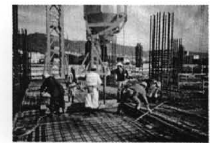
⑥ はりと床のコンクリート打設
