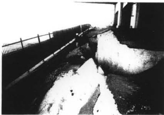
写真-1 橋脚の前面地盤の崩壊 5) (橋脚の北側より撮影)
