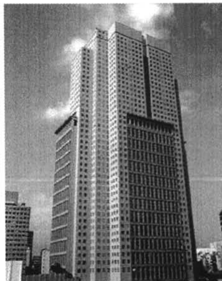
写真-1 建物の全景
