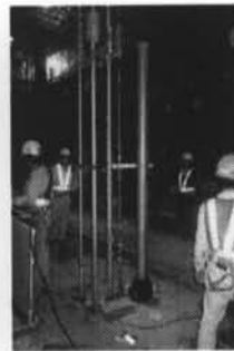
②配管先行立上完了
