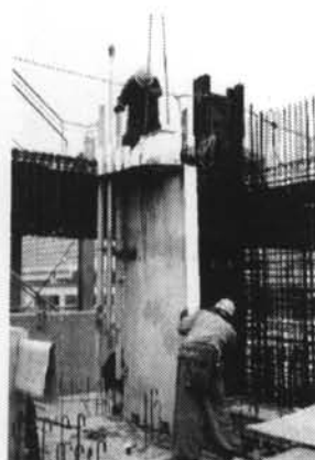
写真-3 躯体据付
