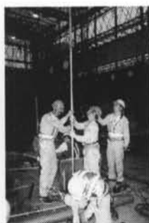
①配管を先行立上げ
