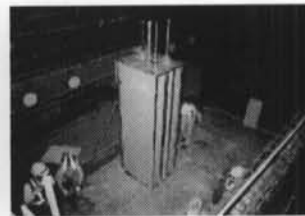
④据付完了
