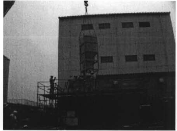
写真-1 コンクリートの打込み状況
