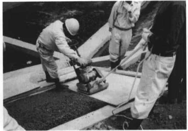
写真一 5 締め固め状況
