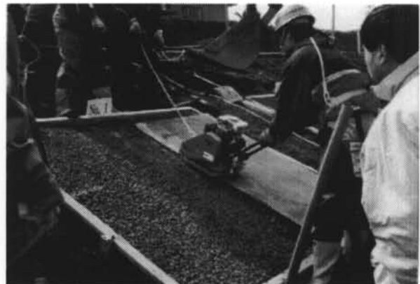
写真-1 締固め状況 (のり面垂直方向)
