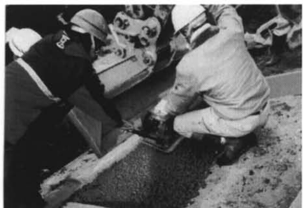
写真-2 締固め状況 (重力方向)
