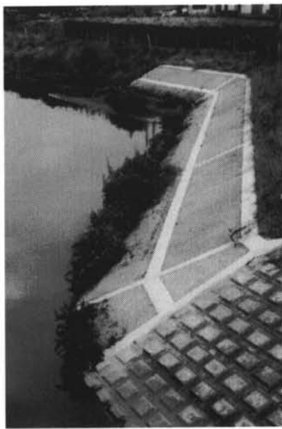
写真一 6 施工後 12ヶ月の状況
