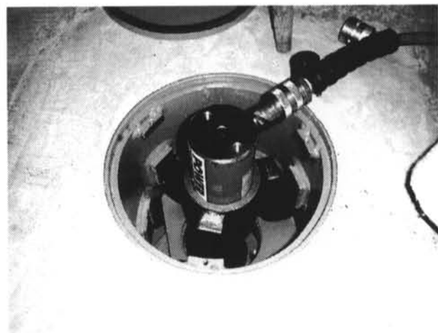
写真-2 油圧ジャッキを用いたリフトアップ作業
