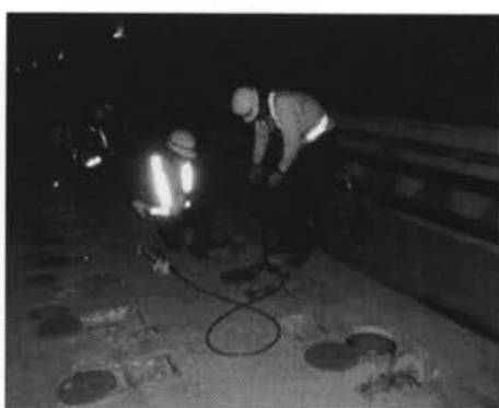
写真-7 試験軌道 ジャッキアップ
