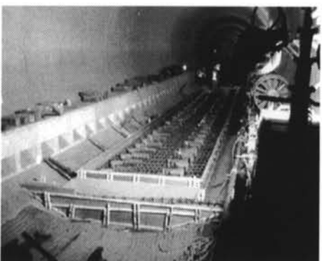
写真-5 試験軌道 配筋・型枠
