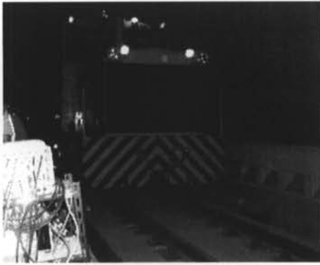
写真-9 軌道モーターカー
