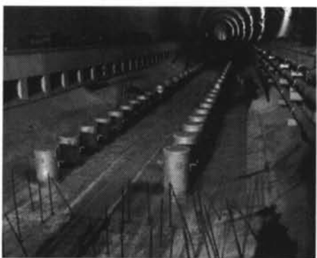
写真-4 試験軌道 ばねハウジング配置
