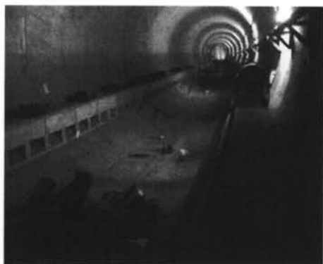
写真-3 試験軌道 施工開始時
