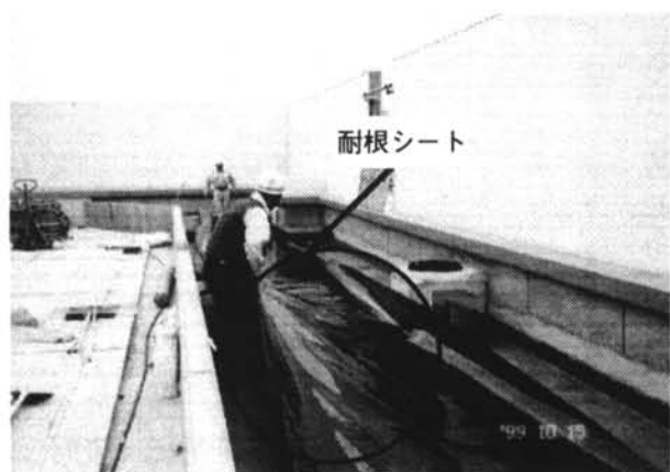
写真-10 耐根シートの施工
