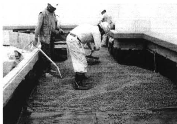
写真-11 排水層の施工
