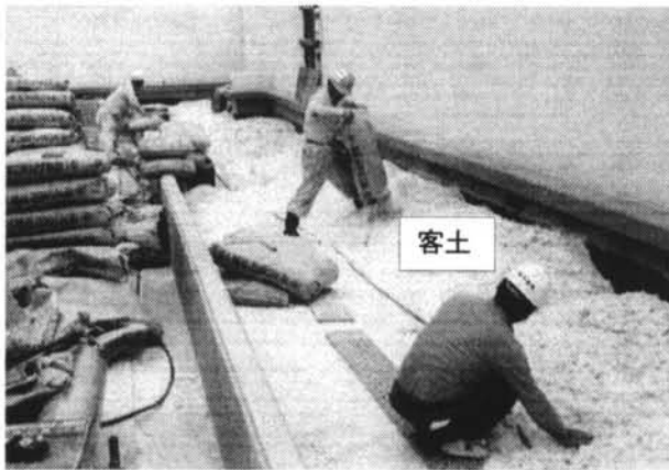
写真-13 客土の施工
