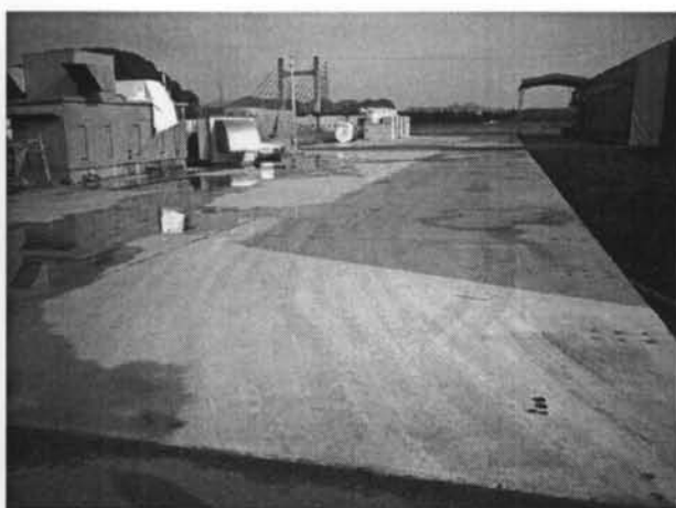
写真-2 B施設のコンクリート基礎の外観
