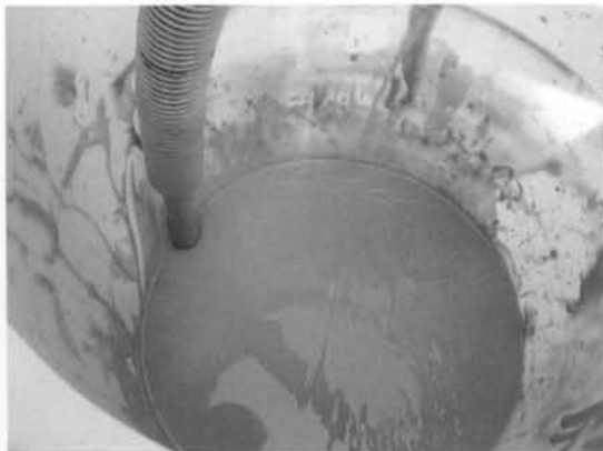
写真-6 圧送中のスラリー
