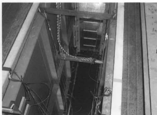
写真-1 仕切り板による止水壁部分の構築
