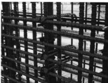
写真—3 側壁のせん断補強筋
