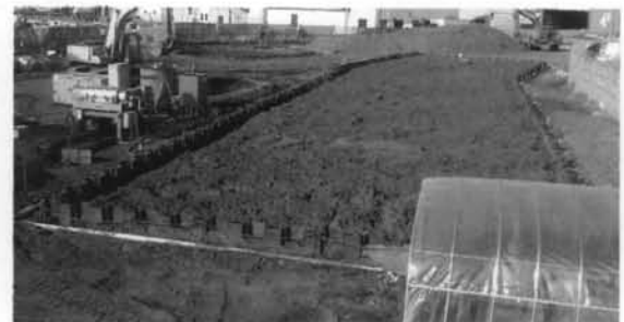
写真-1 バイオミキシング槽外観
